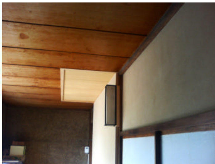
小屋裏までの補強のため、天井に開口を設け、新建材で補修
