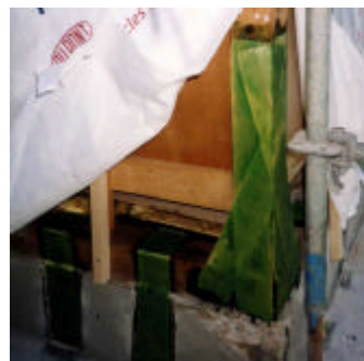
アラミド繊維による施工
