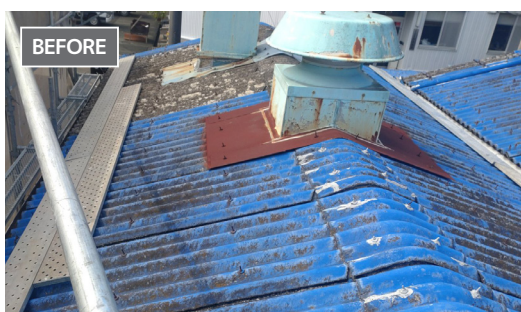
■スレート屋根 スレート屋根を補強しアスベスト飛散防止も
