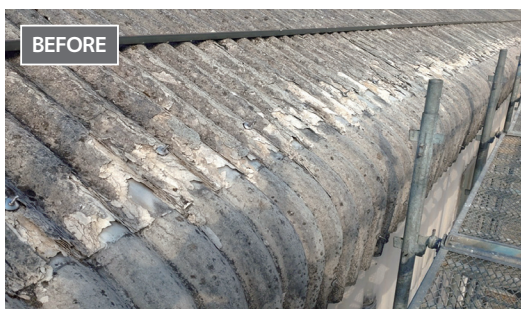
■スレート屋根 劣化し屋根表面が剥がれたスレート屋根を補修・補強
