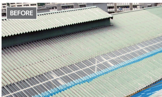
■折板屋根 劣化した箇所に被せた屋根材ごと補修・補強
