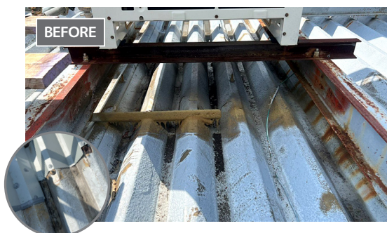
■スレート屋根 スレート屋根を補強しアスベスト飛散防止も
